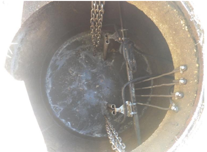
Poste de refoulement récupérant les effluents EU de l'entreprise (en charge au début de la visite)
