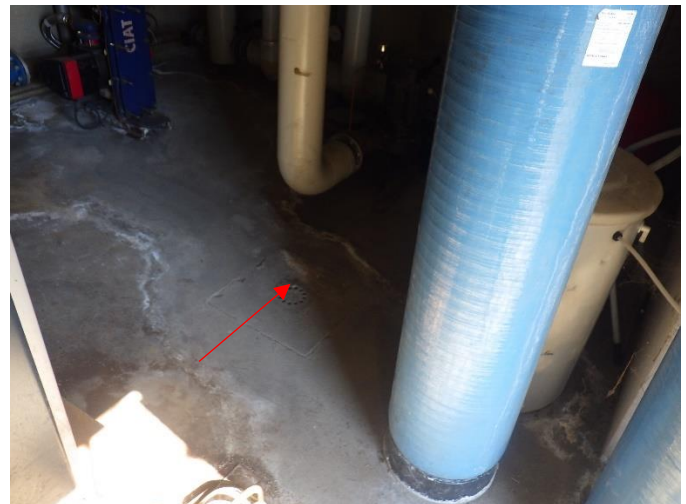
Poste de refoulement récupérant les effluents EU de l'entreprise (en charge au début de la visite)
